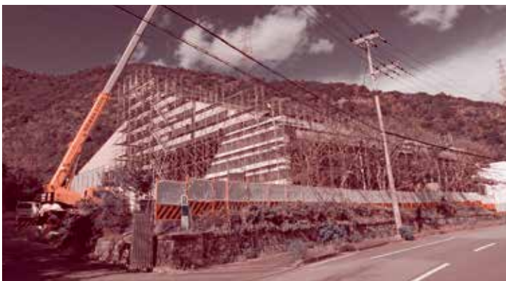
取りこわし工事中のアクア交流館
