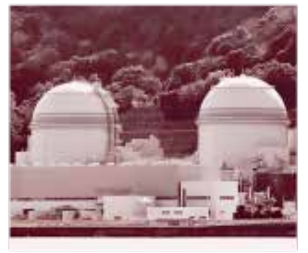
高浜原子力発電所
