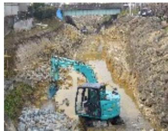
台風による擁壁の崩れを仮復旧していた喜瀬川で本格的な復旧工事が進められています。
