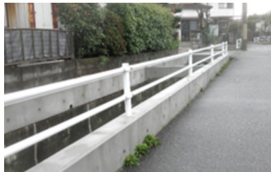
西谷神社横の水路に設置された越水防止ブロック
