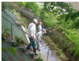
中部中学校北の新井用水内での作業
